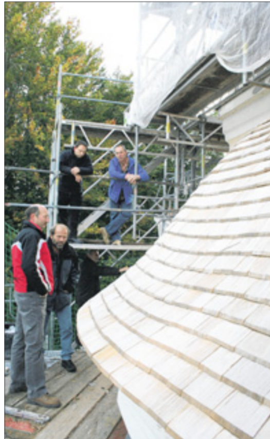
Pater Jörg Weinbach (links auf dem Gerüst) zeigt den Fortgang der Bauarbeiten.
