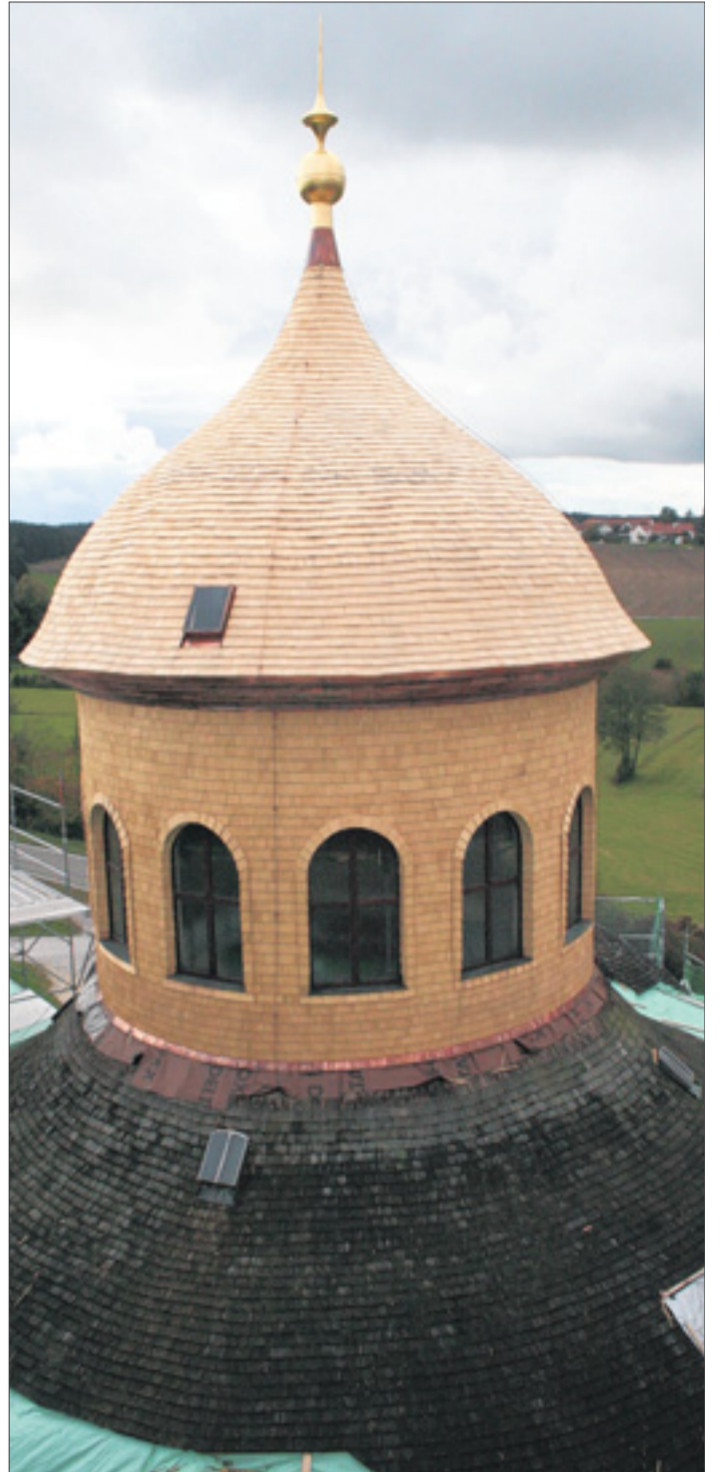
Die neuen Alaska-Schindeln vertreiben nicht nur Motten, sondern machen sich auch besonders gut auf dem Turmdach von Maria Birnbaum. Fotos: Nadja Aswad
